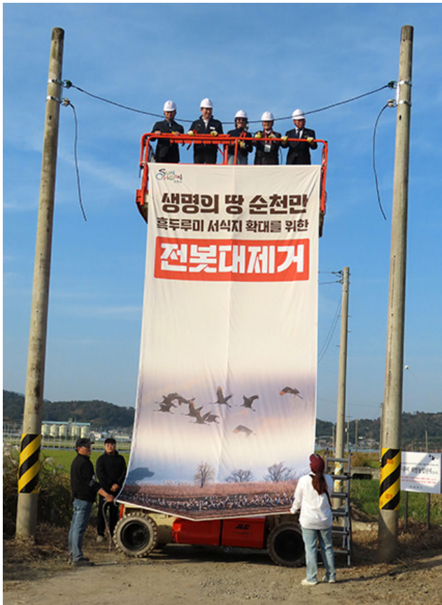
Рис. 13. Участие в демонтаже ЛЭП. Фото Е. Ильяшенко Fig. 13. Participation in removal of power lines. Photo by E. Ilyashenko
