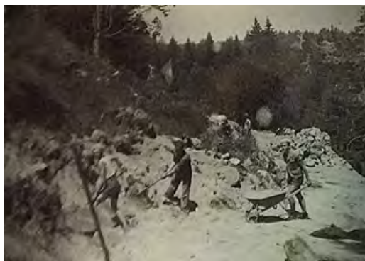
Строительство автодороги в горах.
