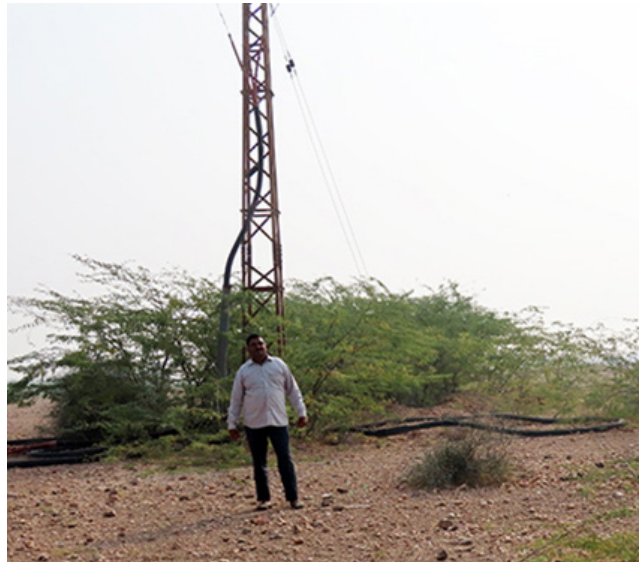
Рис. 16. Севарам Мали рядом с участком, где закопана часть ЛЭП в месте перелёта красавок из пустыни на место подкормки. Фото Е. Ильяшенко
