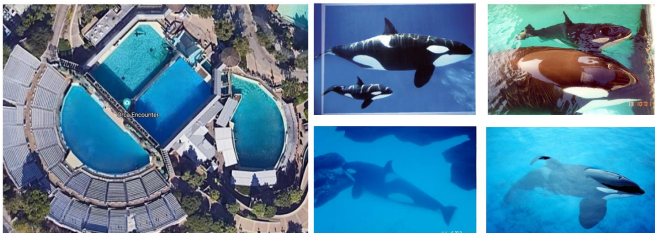
Рисунок 3.3. Комплекс бассейнов в океанариуме SeaWorld в г. Сан-Диего. К демонстрационному бассейну в форме полукруга примыкают 2 прямоугольных бассейна, правый соединяется через канал с другим полукруглым бассейном с подводным окном, в котором раньше содержался серый кит. В левом ряду – видеосъемка через смотровое окно, в правом – с наблюдательных пунктов над бассейнами. Фотографии косаток Лямина О.И.
