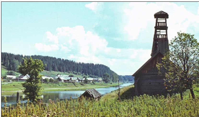
Пожарная каланча в деревне Мартьяново. В начале XIX века по приказу Александра Первого пожарные каланчи были построены по всей Руси
