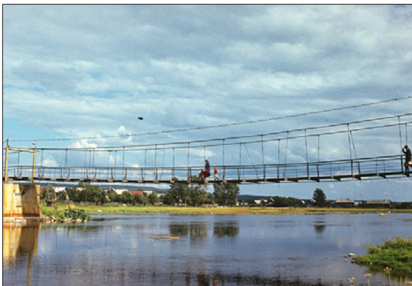
Висячий мост в Староуткинске, соединяющий поселок, расположенный на противоположных берегах
